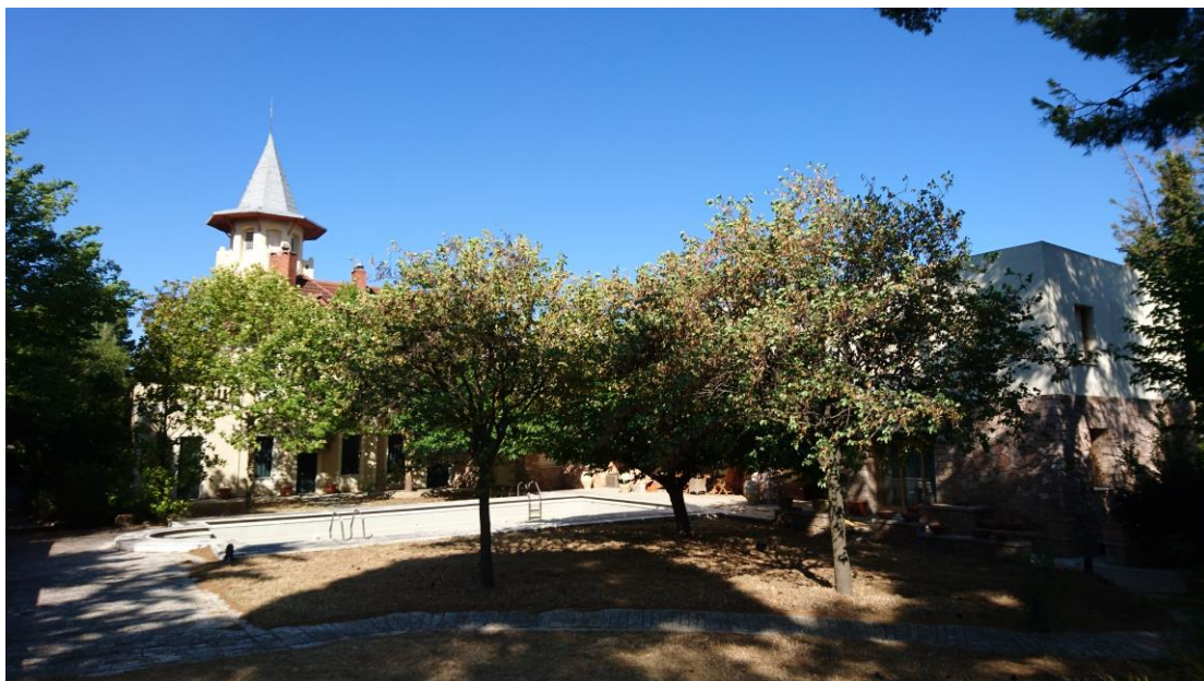
Εξωτερική άποψη κτιρίου από τα ανατολικά και τμήμα περιβάλλοντα χώρου
